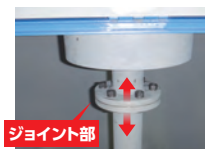
ジョイント部 ジョイント構造
